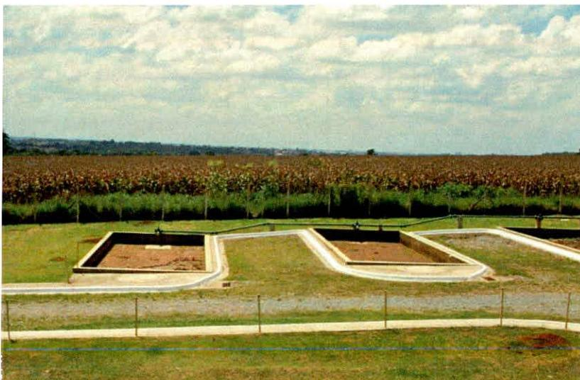
Tanques desativados de acúmulo de lodo dos decantadores e água de lavagem dos filtros. Foto de 2019. Fornecida pela Empresa Águas de Araçoiaba.
