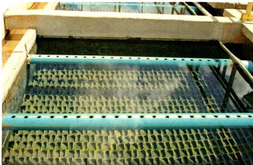
Detalhes dos decantadores – canaletas tubulares de PVC inclinadas. Foto de 2019. Fornecida pela Empresa Águas de Araçoiaba.
